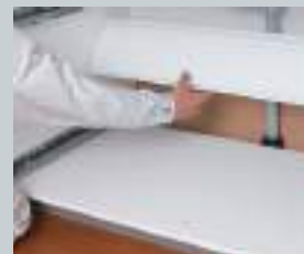
着脱可能で作業がしやすい配管スペース
